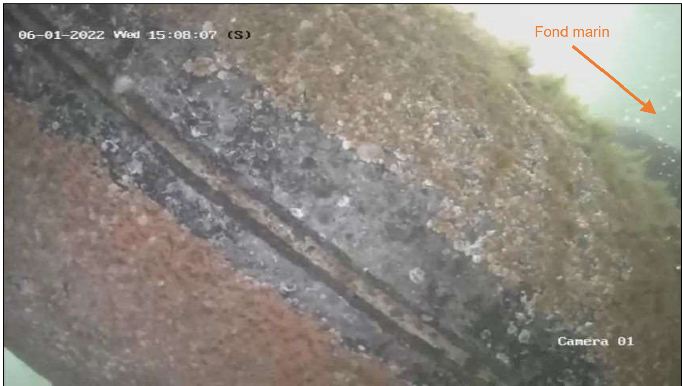
PHOTO 19 – PIEU 58E – FISSURATION / DÉCHIREMENT DE LA SOUDURE VERTICALE DU PIEU EN ZONE DE MARNAGE
