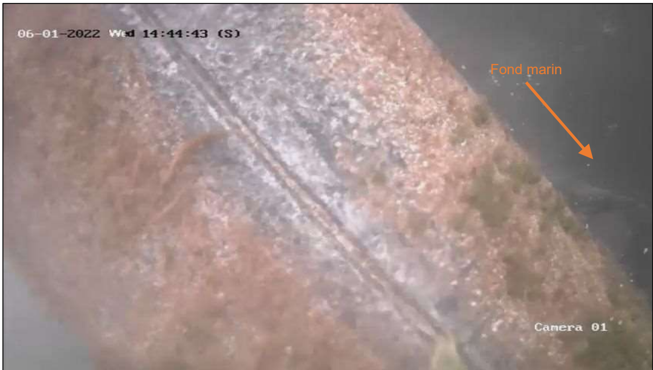
PHOTO 21 – PIEU 61E – FISSURATION / DÉCHIREMENT DE LA SOUDURE VERTICALE DU PIEU EN ZONE DE MARNAGE
