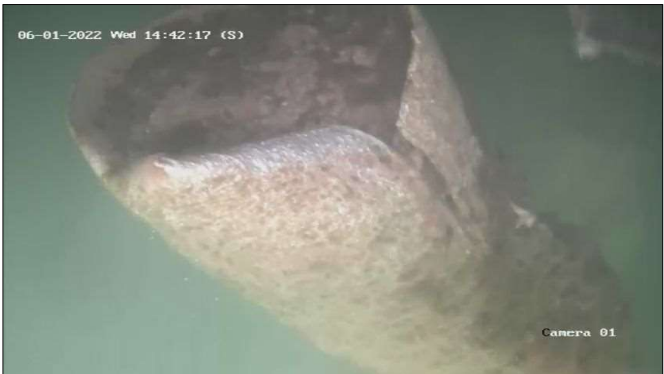
PHOTO 24 – PIEU 62E – PIEU SECTIONNÉ SOUS L'EAU
