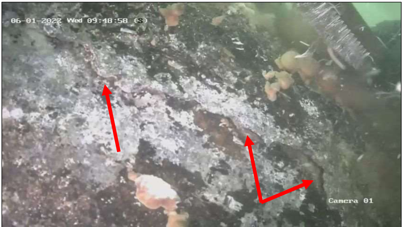
PHOTO 23 – PIEU 68A – CORROSION AVEC STRATES D'ACIER EN ZONE DE MARNAGE
