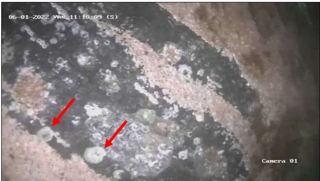
PHOTO 22 – PIEU 65A – CRATÈRES DE CORROSION D'AU PLUS 10 MM DE DIAMÈTRE EN ZONE DE MARNAGE
