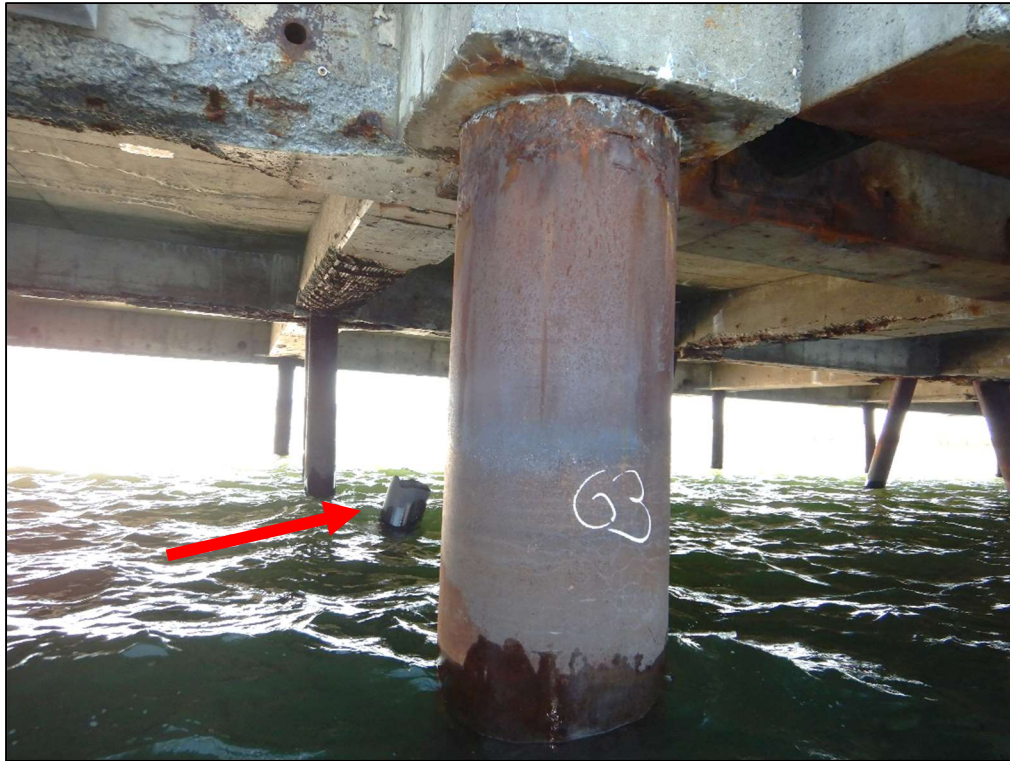
PHOTO 25 – PIEU 63A – PIEU SECTIONNÉ VISIBLE À LA SURFACE DE L'EAU
