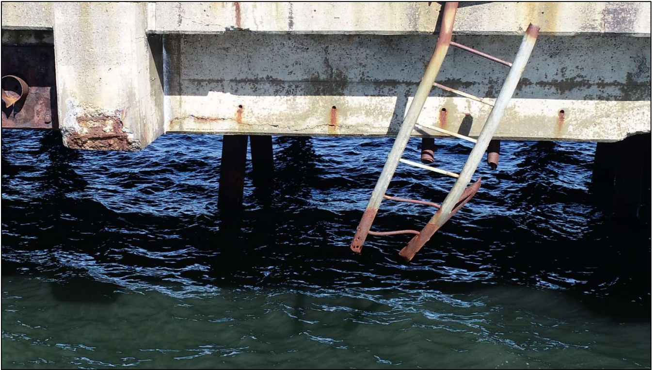
PHOTO 33 – TRAVÉE N°64 (POUTRE LONGITUDINALE OUEST) – ZONE DE DÉLAMINAGE
