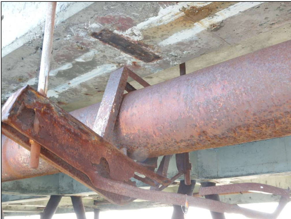
PHOTO 42 – TRAVÉE N°45 (EST) – TUYAU DONT LES ANCRAGES SONT PERFORÉS ET DÉFORMÉS
