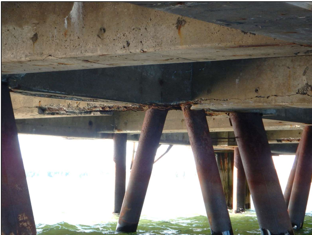
PHOTO 32 – TRAVÉE N°60 – ZONE DE DÉLAMINAGE SUR TOUTE LA LONGUEUR DE LA POUTRE
