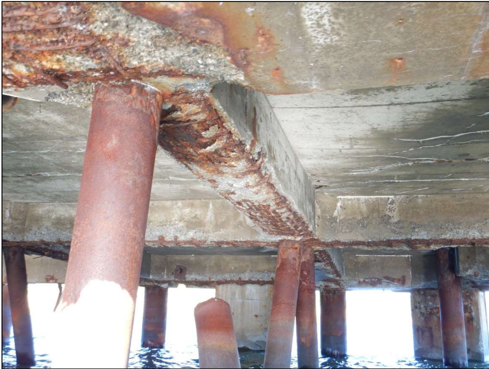
PHOTO 31 – TRAVÉE N°66 – ZONE D'ÉCLATEMENT AVEC ARMATURES APPARENTES
