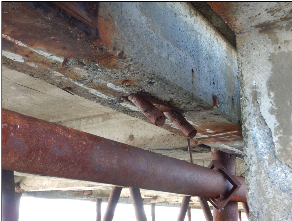
PHOTO 38 – TRAVÉE N°52 – ANCRAGES D'UNE ÉCHELLE MANQUANTE
