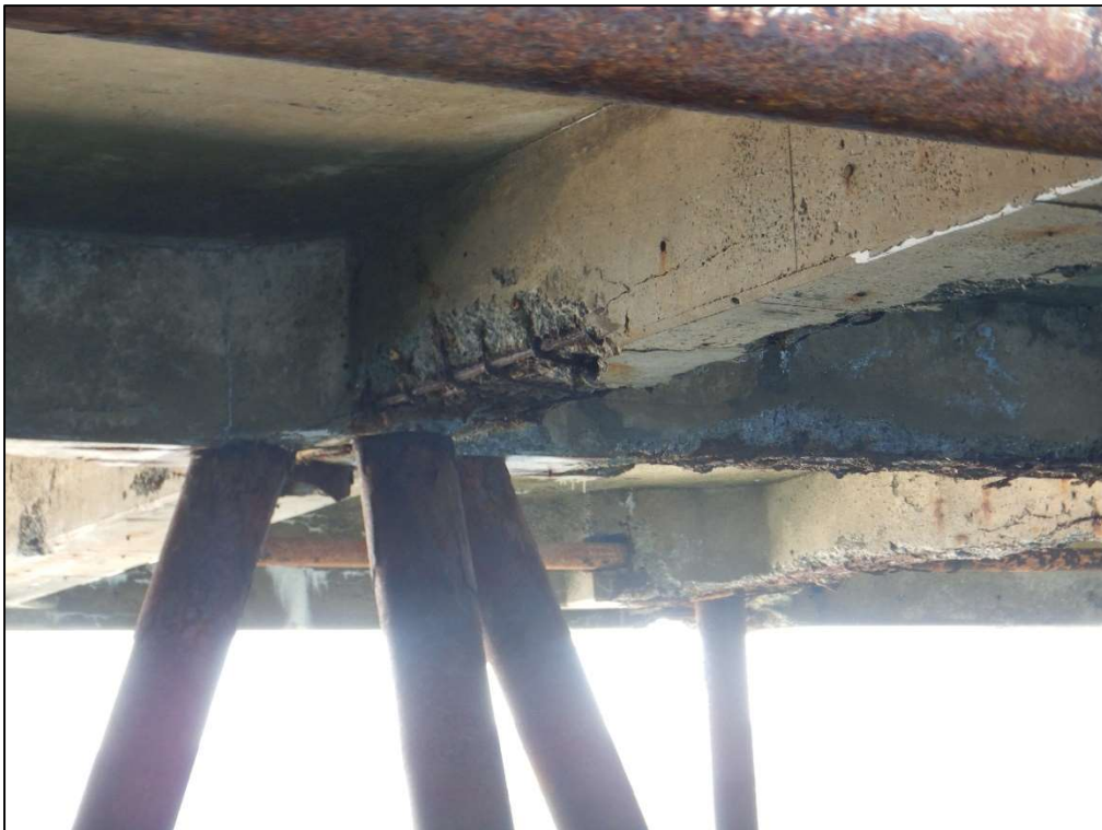
PHOTO 28 – TRAVÉE N°55 – ZONE D'ÉCLATEMENT AVEC ARMATURES APPARENTES
