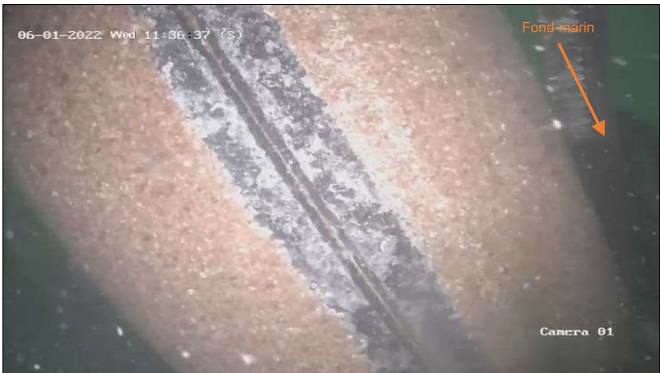
PHOTO 20 – PIEU 60C – FISSURATION / DÉCHIREMENT DE LA SOUDURE VERTICALE DU PIEU EN ZONE DE MARNAGE
