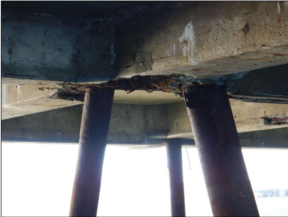
PHOTO 29 – TRAVÉE N°61 – ZONE D'ÉCLATEMENT AVEC ARMATURES APPARENTES SECTIONNÉES
