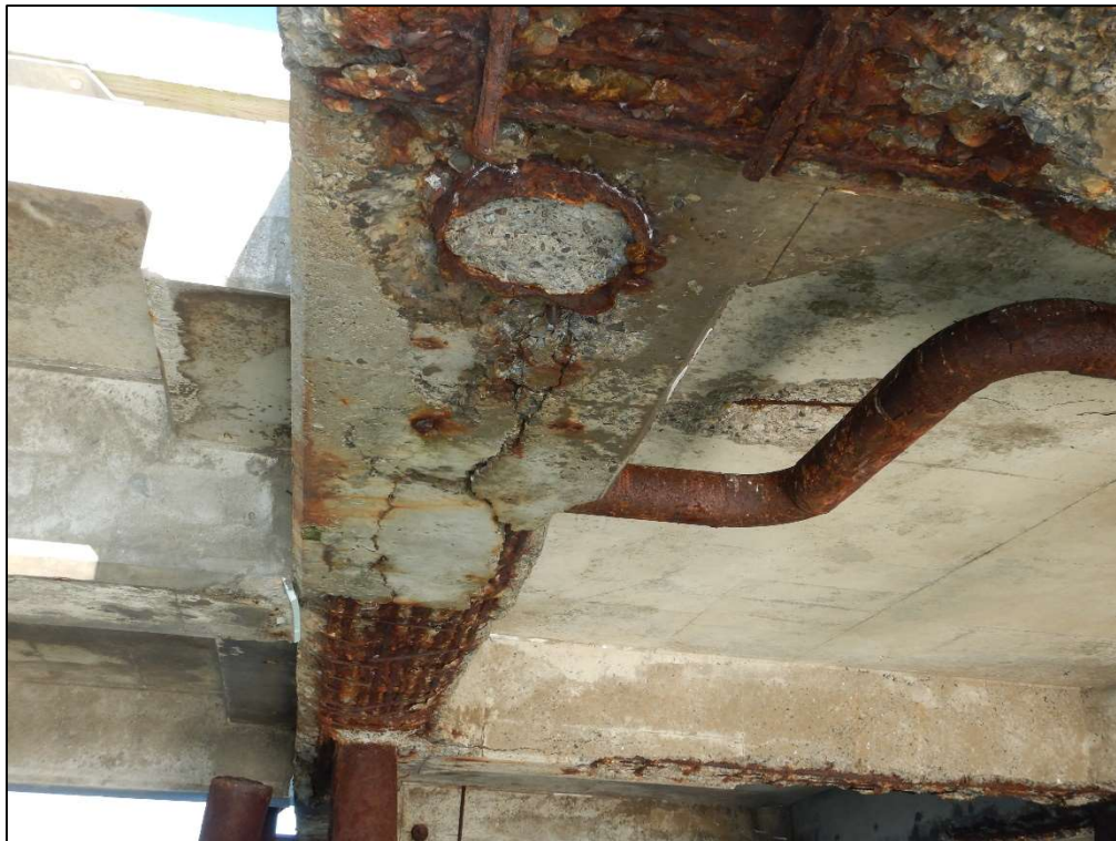
PHOTO 36 – TRAVÉE N°45 – PIEU SECTIONNÉ DONT LE BÉTON EST DE COULEUR « GRIS BÉTON »
