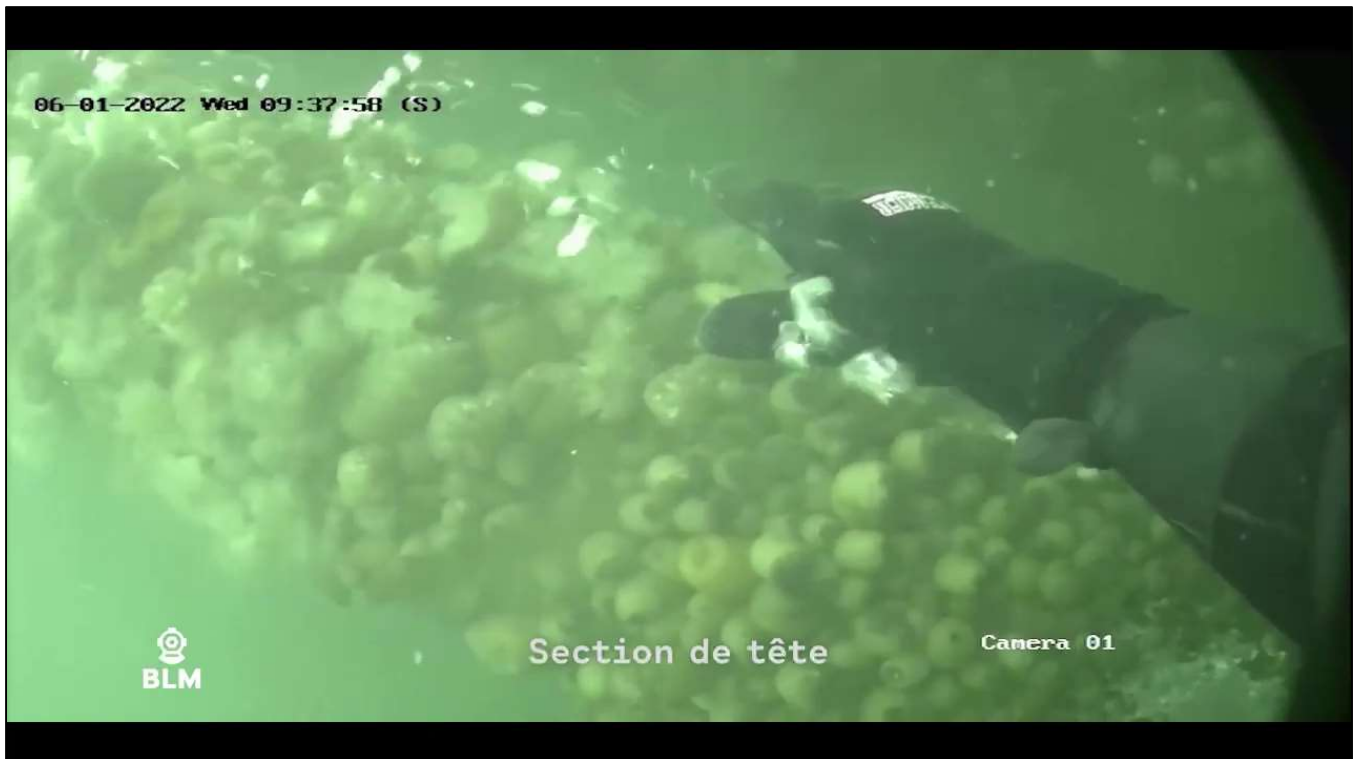
PHOTO 18 – PIEU RECOUVERT DE SALISSURES MARINES
