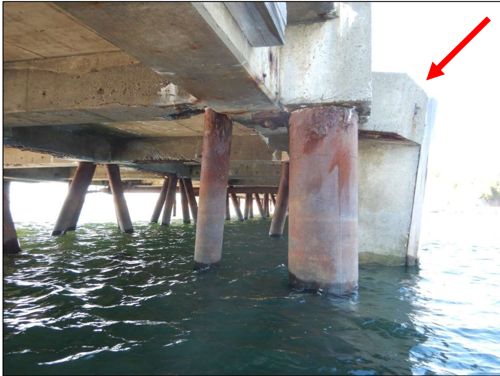
PHOTO 39 – TRAVÉE N° 58 (EST) – VERTICALITÉ DÉFICIENTE DE LA DÉFENSE
