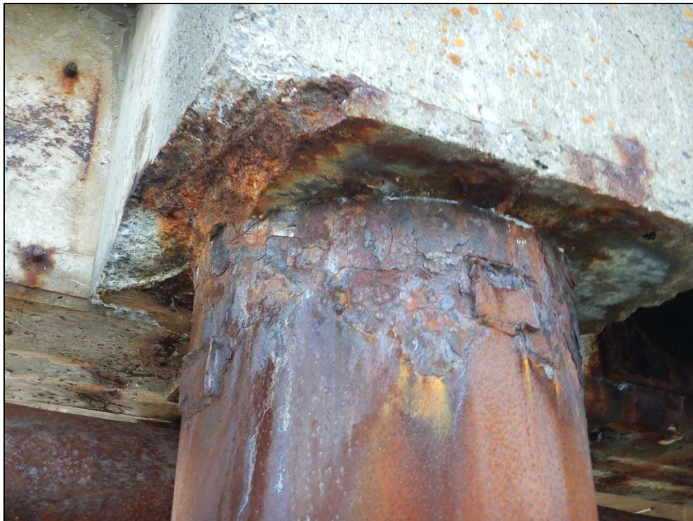
PHOTO 26 – PIEU 55A – CORROSION IMPORTANTE À LA TÊTE DE PIEU
