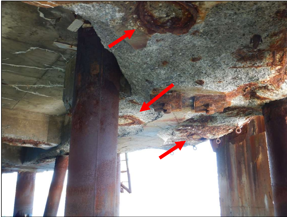
PHOTO 35 – TRAVÉE N°67 – TROIS (3) PIEUX SECTIONNÉS DONT LE BÉTON EST DE COULEUR « ROUILLE »
