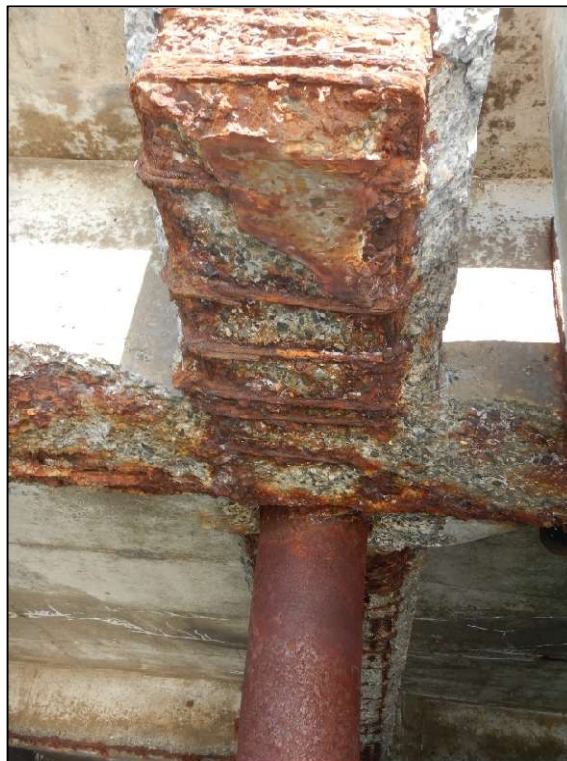
PHOTO 30 – PIEU 65E – ZONE D'ÉCLATEMENT AVEC ARMATURES APPARENTES
