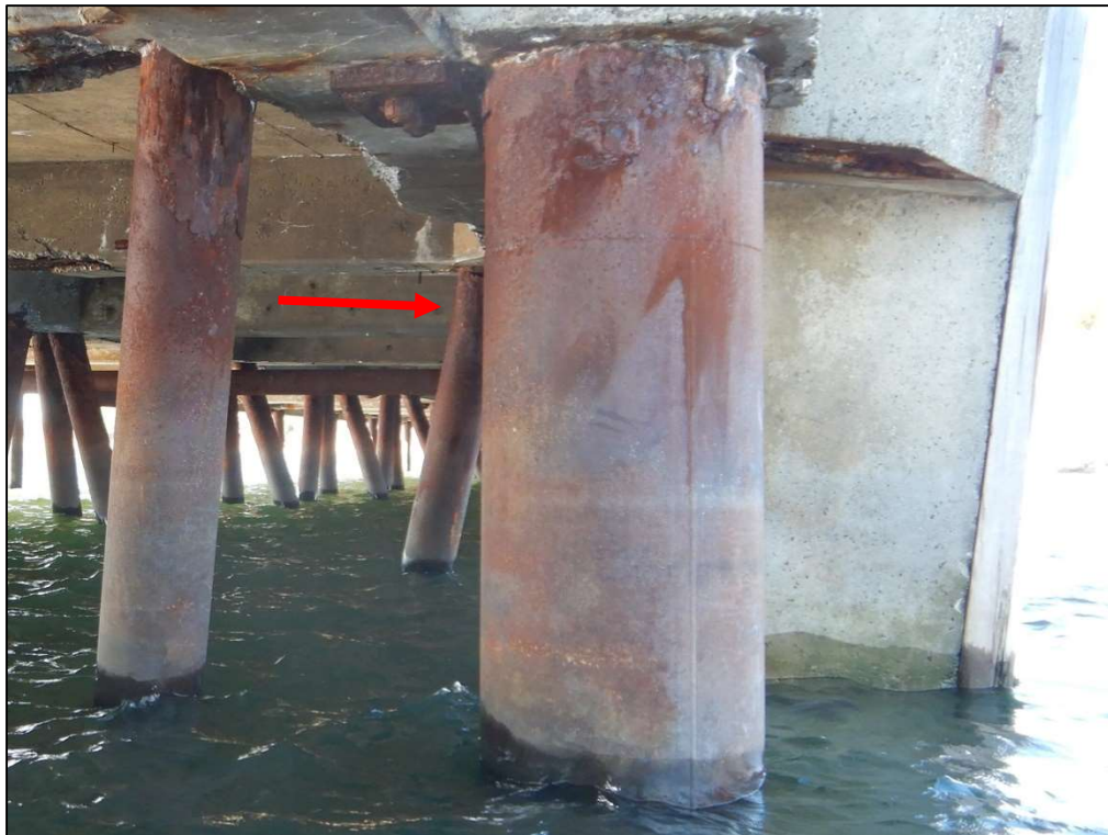
PHOTO 34 – PIEU 58B – DÉFORMATION PERMANENTE
