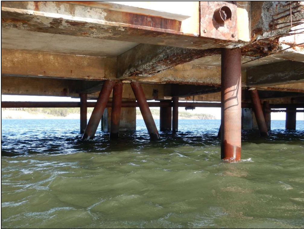
PHOTO 27 – TRAVÉE N°54 – ZONE D'ÉCLATEMENT AVEC ARMATURES APPARENTES SECTIONNÉES
